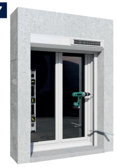
Fixer les coulisses, ajuster si besoin. **IMPORTANT**: le type de fixation et dimensionnement doit être adapté au support, le niveau de protection répondra à la classification de corrosion en rapport à la norme NF EN 1670.
