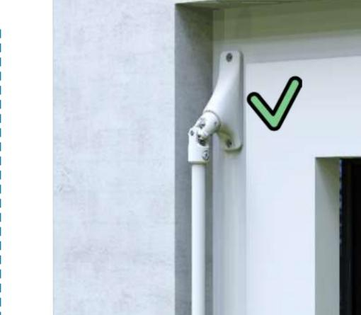
Insérer la tige d'attaque recoupée du renvoi de mouvement dans la menuiserie et dans le coffre
