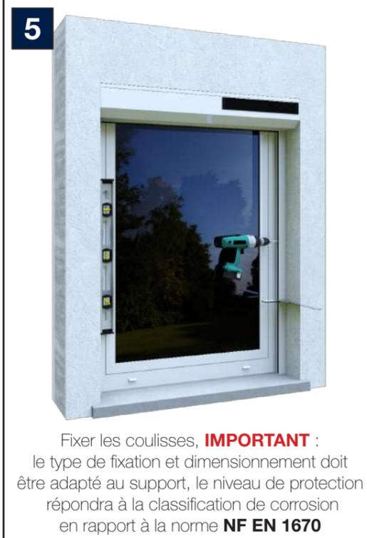
Fixer les coulisses, **IMPORTANT** : le type de fixation et dimensionnement doit être adapté au support, le niveau de protection répondra à la classification de corrosion en rapport à la norme **NF EN 1670**
