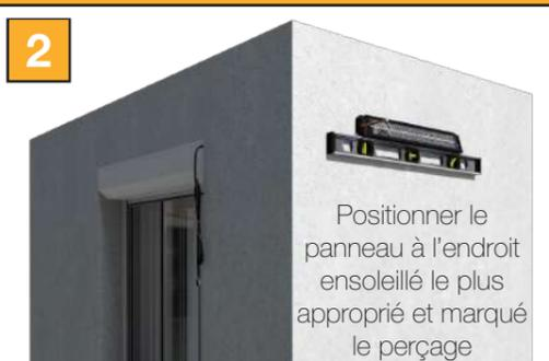
Positionner le panneau à l'endroit ensolleillé le plus approprié et marqué le perçage
